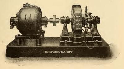
FIG. 408.—CHARGING MOTOR GENERATOR—ALTERNATING-CURRENT MOTOR.
