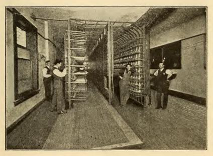
FIG. 496.—VIEW OF DISTRIBUTING FRAMES AND RELAY RACK—LOS ANGELES OFFICE.
