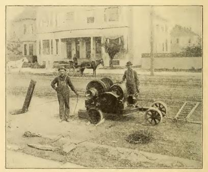
FIG. 621.-ELECTRIC WINCH.
