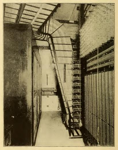
FIG. 482.—END OF INTERMEDIATE DISTRIBUTING FRAME—CORTLANDT STREET OFFICE.
