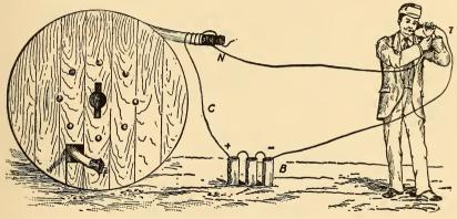
FIG. 624.-RECEIVER TEST FOR CROSSES AND GROUNDS.
