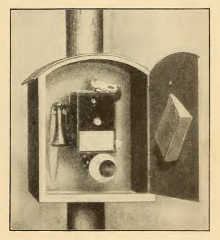
FIG. 340.-STROUD CONTROLLER FOR STREET SERVICE.
