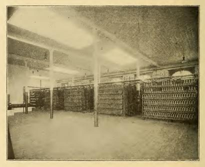
FIG. 520.-SWITCH ROOM IN GRAND RAPIDS AUTOMATIC EXCHANGE.
