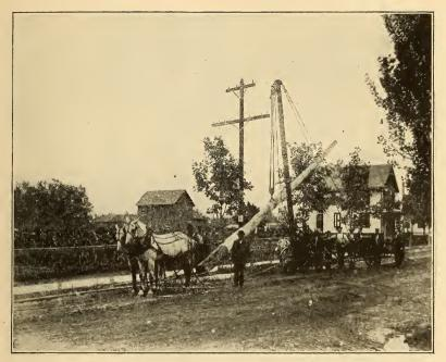
FIG. 559.-DERRICK WAGON-POLE PARTLY RAISED.
